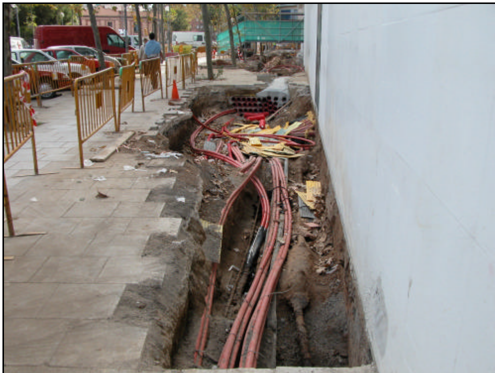
Foto 3: Rebaix efectuat al carrer Nàpols.
