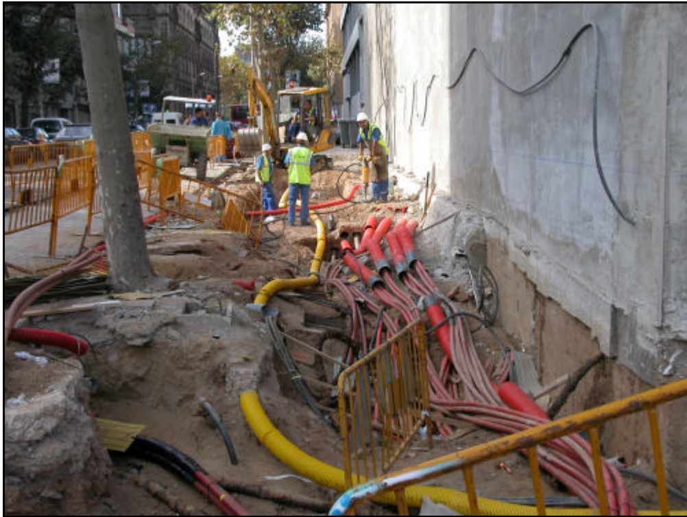
Foto 4: Vista general de les obres al carrer Almogàvers.
